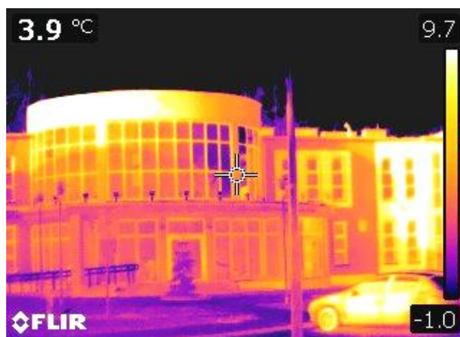
Rys. 1. Termowizyjny widok budynku CNB
